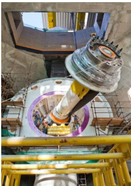
Figura 30 - Giro de 90 graus do Eixo
