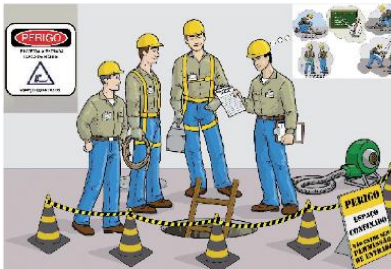
Figura 6 - Isolamento através de cones sinalizadores, fita e placa de aviso
