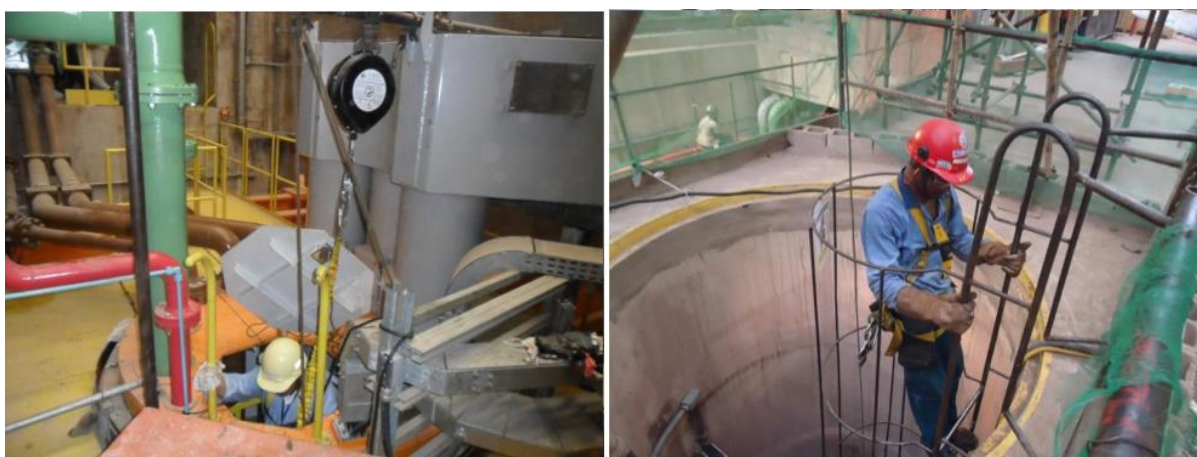
Figura 40 - Trava-quedas retrátil e convencional
